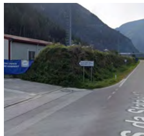
Erdwall als Lärm- und Sichtschutz
