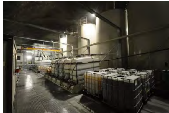
Betonmischung in Kaverne
