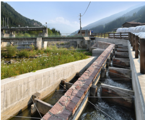
Fischtreppe – Wasserkraftwerk Sarnthein
