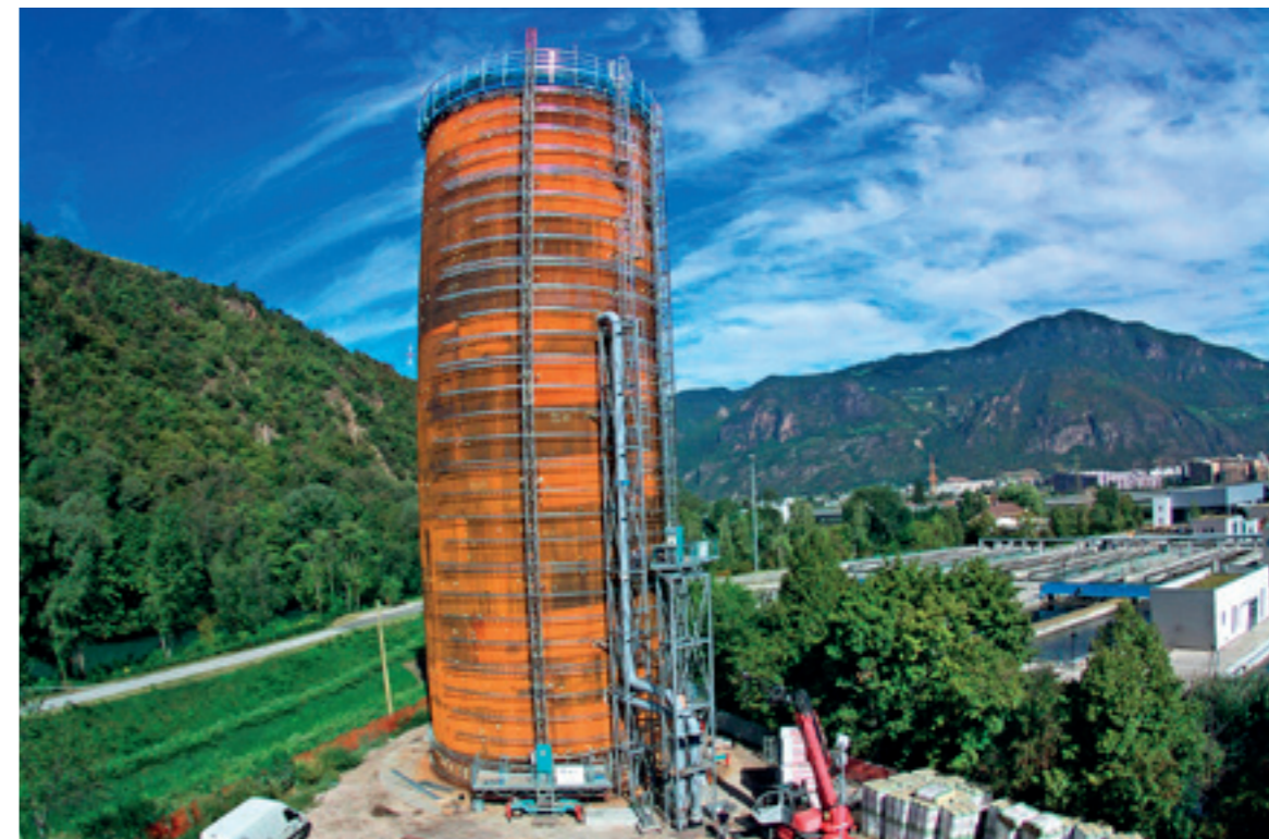
Der neue Wärmespeicherturm des Fernheizwerkes Bozen nimmt Form an.
