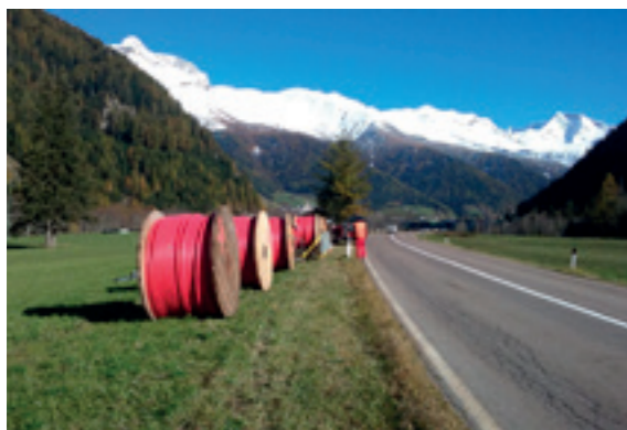
Verlegungsarbeiten der neuen unterirdischen Stromleitung in Pfitsch.
