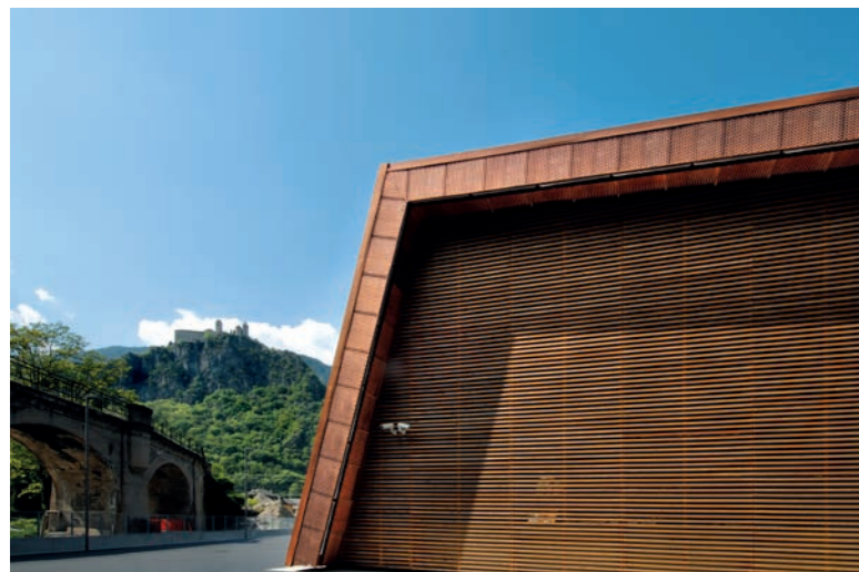
La centrale di teleriscaldamento di Chiusa.
