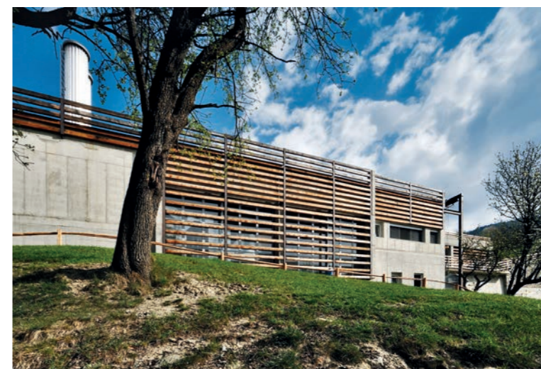
La centrale di teleriscaldamento di Lazfons.
