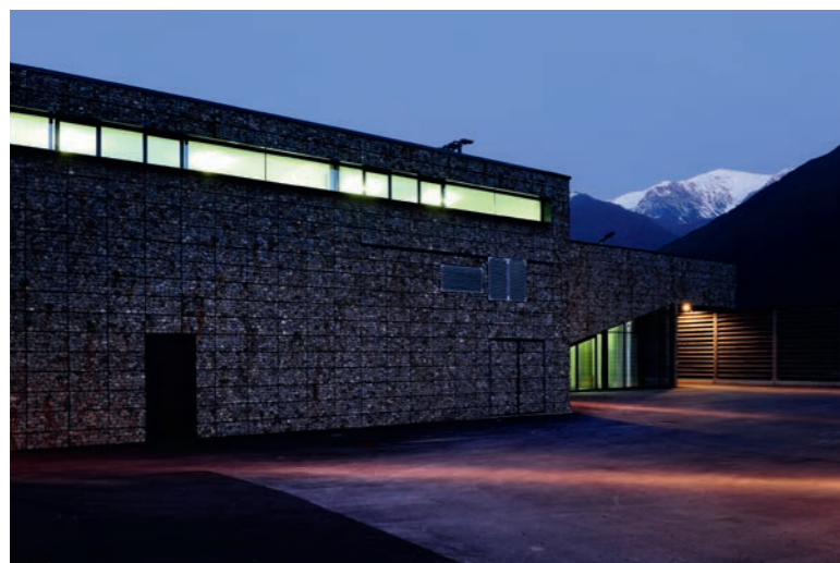
La centrale di teleriscaldamento di Silandro.
