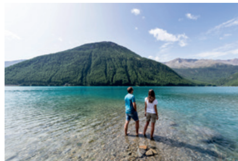
Le acque cristalline del lago artificiale di Vernago in Val Senales. Il bacino alimenta la centrale idroelettrica di Naturno.
