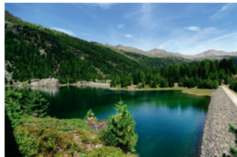
Vista del lago di Fontana Bianca. La particolarità di questo bacino è la presenza di due dighe, una a nord e una a sud, caso unico tra i laghi artificiali altoatesini.
