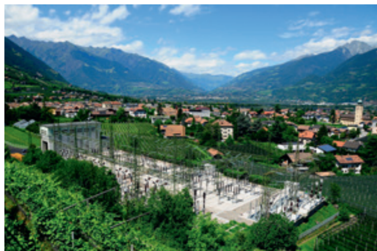
La centrale idroelettrica di Lana.
