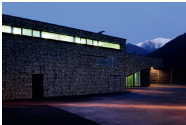
La centrale di teleriscaldamento di Silandro.
