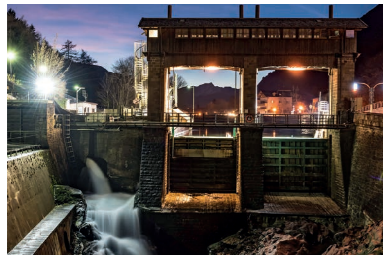
Die Wasserfassung an der Etsch des Wasserkraftwerks Töll.
