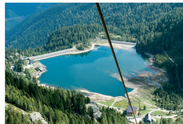
Blick auf das Wasserkraftwerk und den Weißbrunner Stausee mit den beiden Staumauern.
